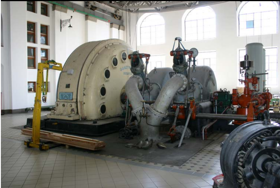
Interno della centrale Senales, le turbine Pelton Courtesy prof. ing. Paolo Bertola UNI
