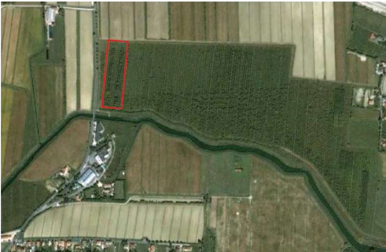
Figura 5: vista aerea dei 30 ha di area tampone realizzati in sponda sinistra rispetto al fiume Zero; l'area evidenziata in rosso è quella oggetto del monitoraggio.
