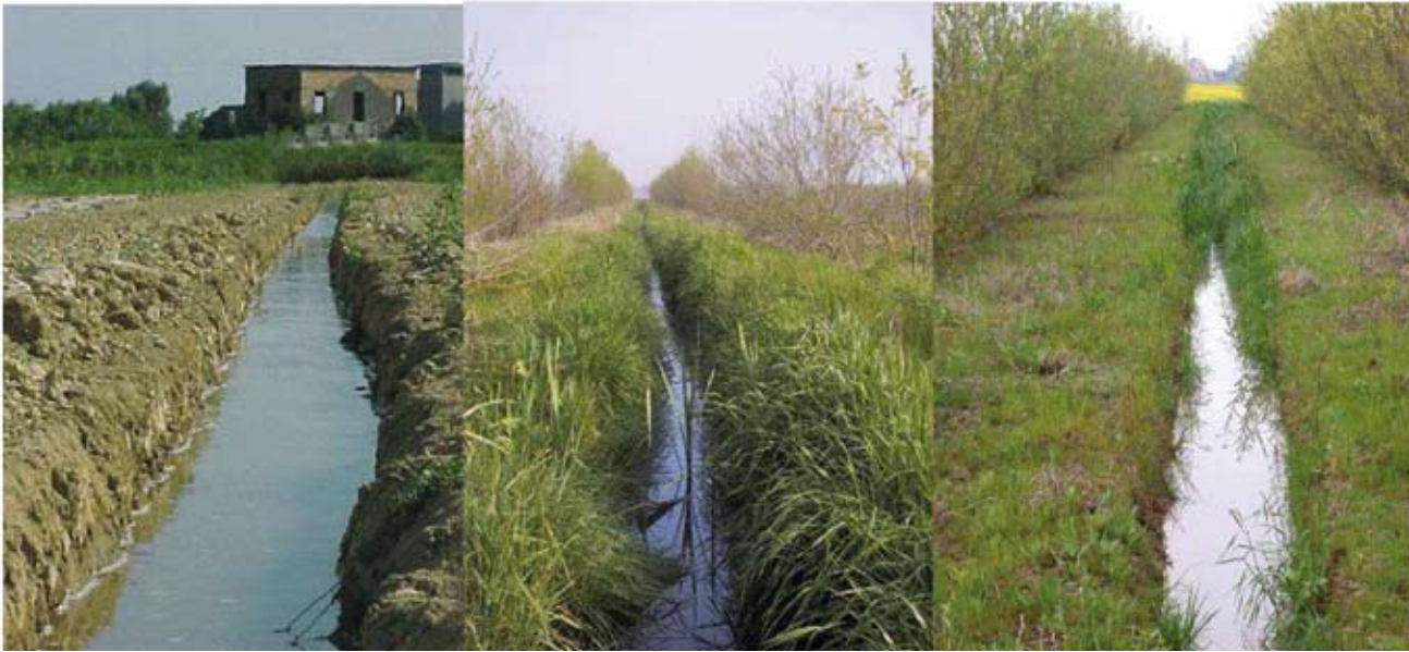
Figura 13: attraverso il confronto fotografico è possibile apprezzare la rapida trasformazione del sito sperimentale dalla condizione iniziale di area ad uso agricolo, in cui sono appena state messe a dimora le piantine forestali (1999) in area tampone boscata (2002 e 2006 nell'ordine).
