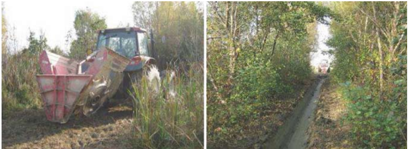
Figura 15: ripristino delle canalette attraverso il passaggio con lo scavafossi.
