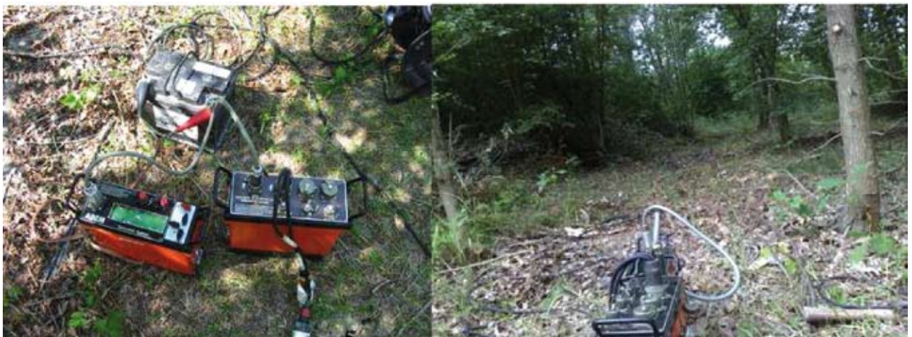
Figura 29: strumentazione e realizzazione di un'indagine ERT.
