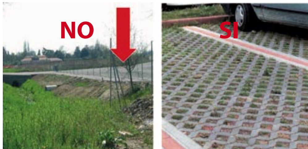
Figura 1: linee guida operative in ambito urbano. A sinistra un esempio di pratica errata, con la cementificazione del terreno che impedisce il corretto deflusso delle acque. A destra, la metodologia appropriata che consente facilmente l'assorbimento da parte del suolo.
