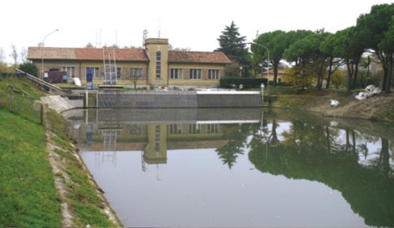
Tessera (Venezia): i locali dell'impianto di sollevamento con le due nuove elettropompe installate
