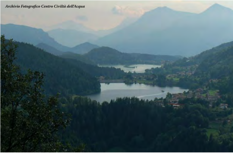
Bacini idroelettrici dell'Altopiano di Pinè (TN).
