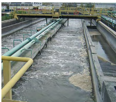
Operazioni di sedimentazione e ossidazione presso gli impianti Veritas di Fusina (VE).
